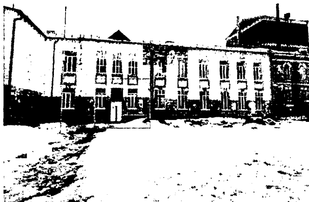
В) Прямоугольный дверной проем на дворовом фасаде
